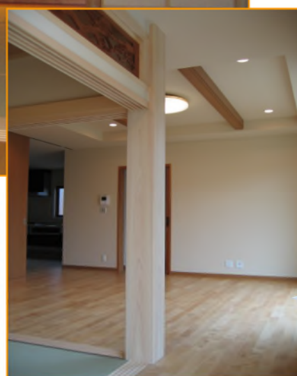
施工例②桧無塗装(太さ210)
